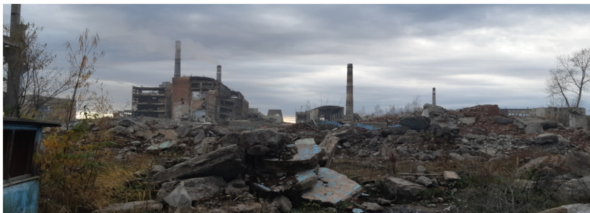
Рис. 5. Скопление уже очищенных ранее обломков перекрытий второго этажа и других относительно чистых конструкций с чрезвычайно загрязненным Hg грунтом первого этажа (ноябрь 2019 г.)
